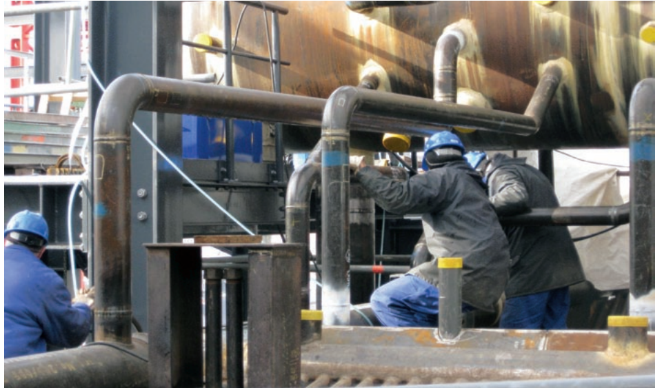
Mit größter Sorgfalt werden die Montagearbeiten am Dampfsystem durchgeführt.
