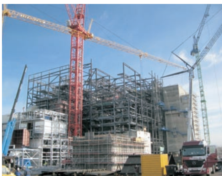
Die Bauarbeiten am Heizkraftwerk liegen voll im Zeitplan, derzeit werden u. a. die Filter für die Rauchgasreinigung installiert.
