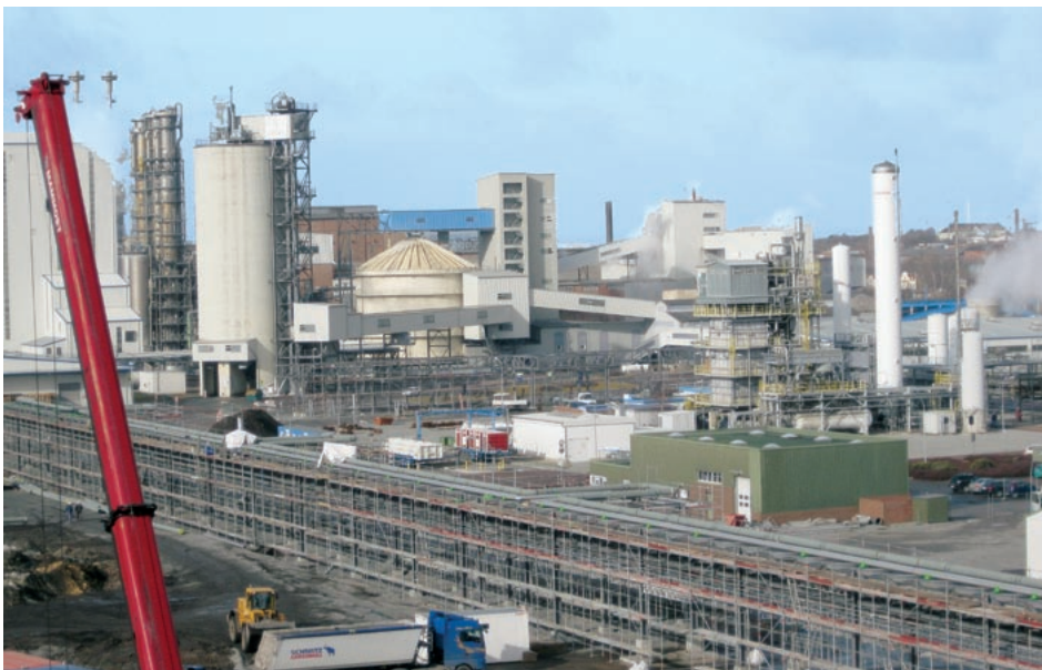
Die Arbeiten an der Dampftrasse zur Solvay-Produktion stehen kurz vor dem Abschluss.
